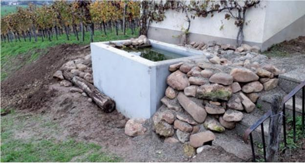
**Abb. 4:** Fortpflanzungsgewässer der Geburtshelferkröte in Form eines Betonbeckens bei Eimeldingen (Kreis Lörrach). An der linken Seitenwand sind Gesteinsbrocken als Versteck für Kaulquappen und als Ausstiegshilfe für Jungkröten geschichtet.
