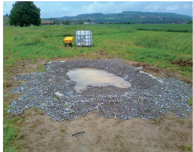
Abb. 8: Bau eines künstlichen Laichgewässers für Kreuzkröten in Form eines Folienteiches mit Kiesauflage bei Eimeldingen.
