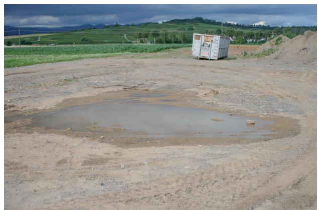
Abb. 7: Tümpel im Bereich einer Großbaustelle der Bahn bei Efringen-Kirchen. Temporäre Tümpel in diesem Baustellenbereich wurden 2012 und 2013 von Kreuzkröten als Laichgewässer genutzt.
